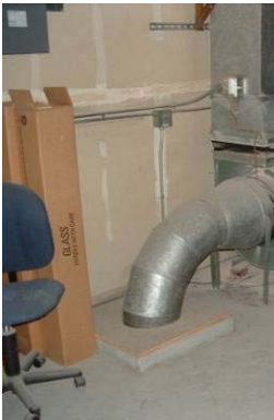
EF-3, NOTE DUST AROUND FAN
